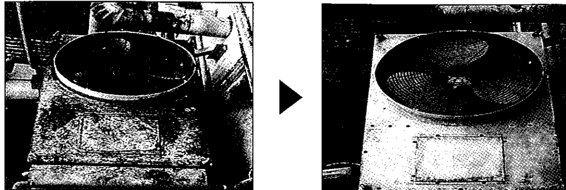
② 排気ダクト壁面: 油汚れ除去 + ガラスコーティング
